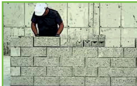
7 Après avoir tendu le cordeau, en partant d'un bloc d'angle posez les blocs en les serrant les uns aux autres.
