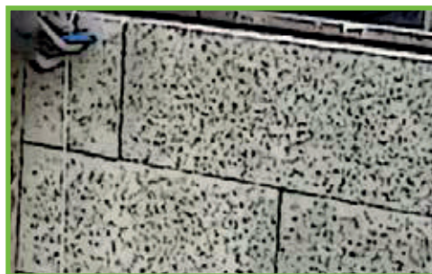
9 Vérifiez l'aplomb à mi-hauteur d'étage.
