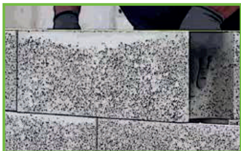
8 Respectez un décalage entre blocs compris entre le tiers et la moitié de la longueur des blocs.
